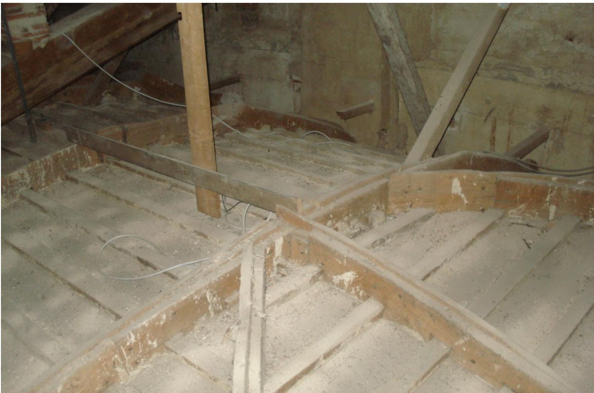
Ambiente 2 sottostante il solaio dell'economato. Volta a incannucciato con centine lignee tipo Delorme.
