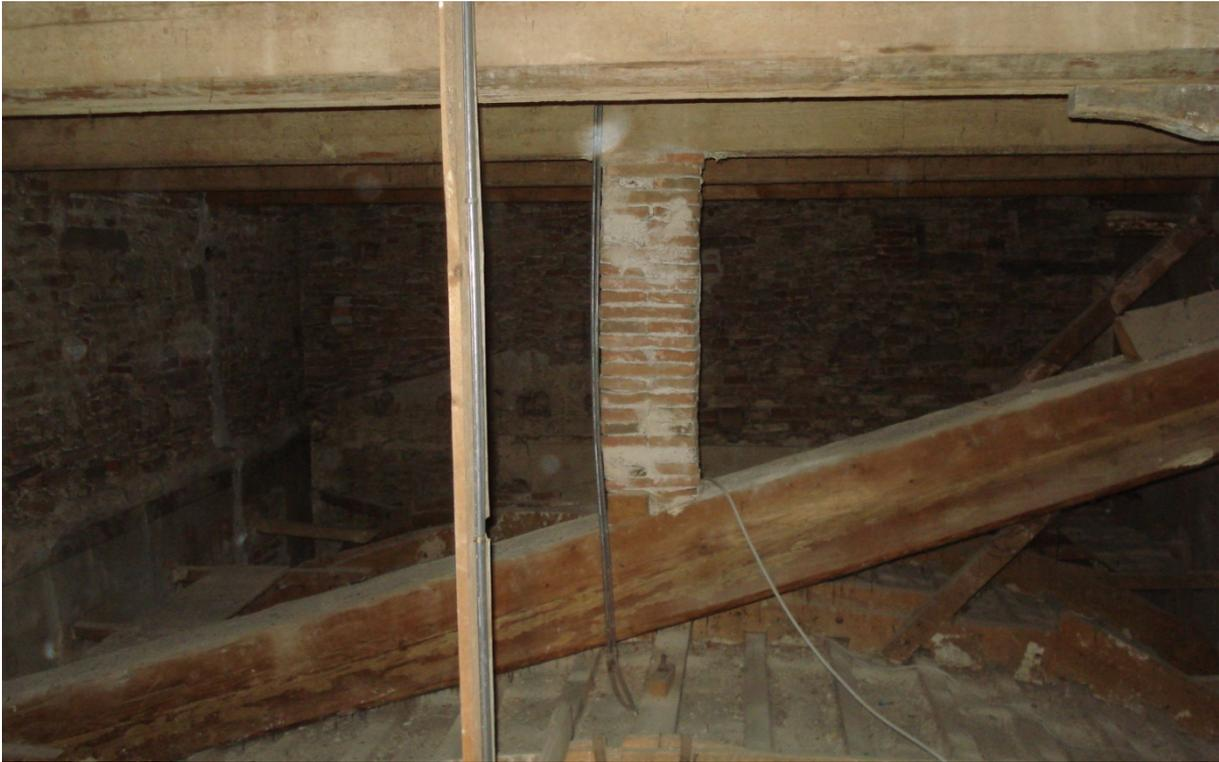
Ambiente 2 sottostante il solaio dell'economato. Pilastrino messo in opera in passato quale intervento di consolidamento messo in atto a contrastare l'inflessione della trave. Si noti che il pilastrino è sottoposto a carico di punta.
