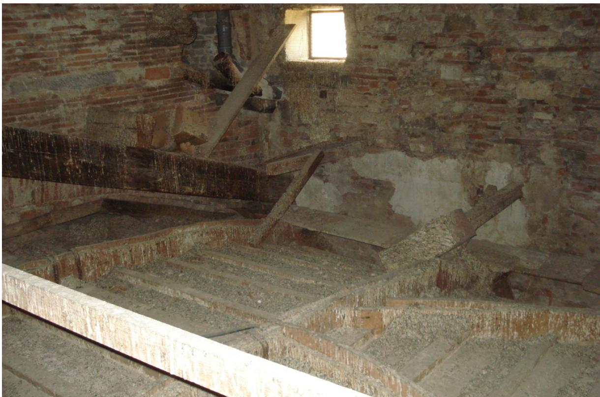
Ambiente 1 sottostante il solaio dell'economato. Volta a incannucciato con centine lignee tipo Delorme. La carpenteria è completamente coperta di guano.
