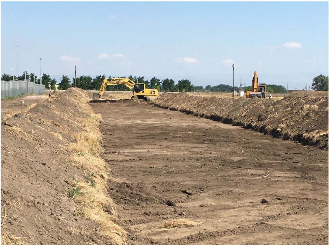
*Immagine 2 - Rimozione del primo strato di terreno con ausilio di mezzo meccanico munito di benna liscia e operaio a terra per vaglio di terreno escavato con ausilio di magnetometro*
