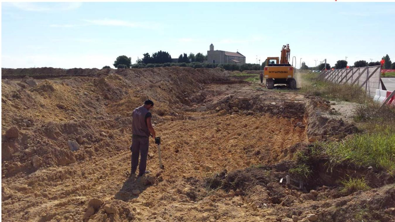
Immagine 6 – Esecuzione ispezione strumentale nelle varie fasi di scavo con ausilio di magnetometro
