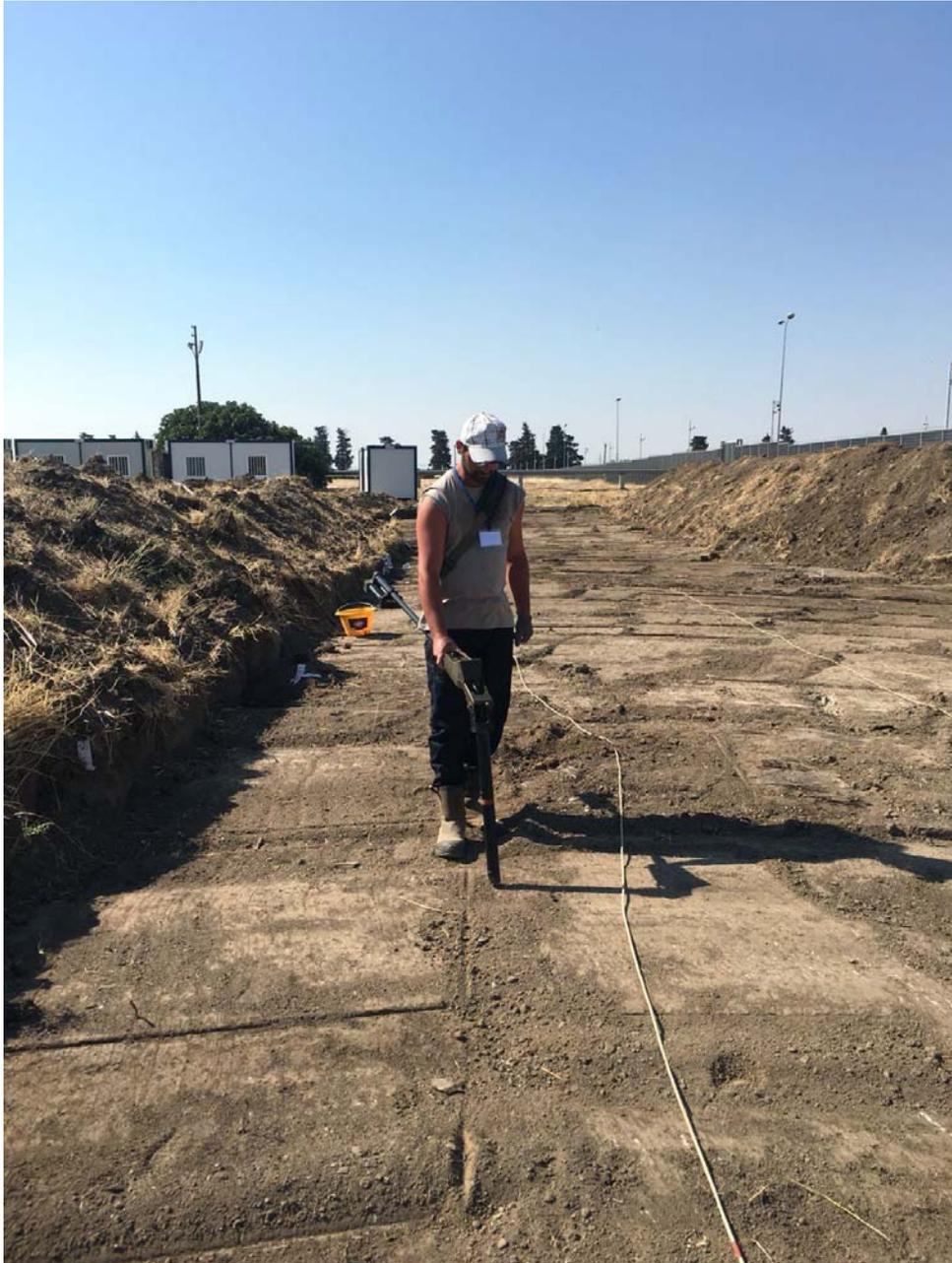
*Immagine 8 - Verifica del fondo scavo mediante bonifica superficiale con suddivisione della fascia in strisce da 0,80 mt. x 0,80 mt. ed ausilio di magnetometro*
