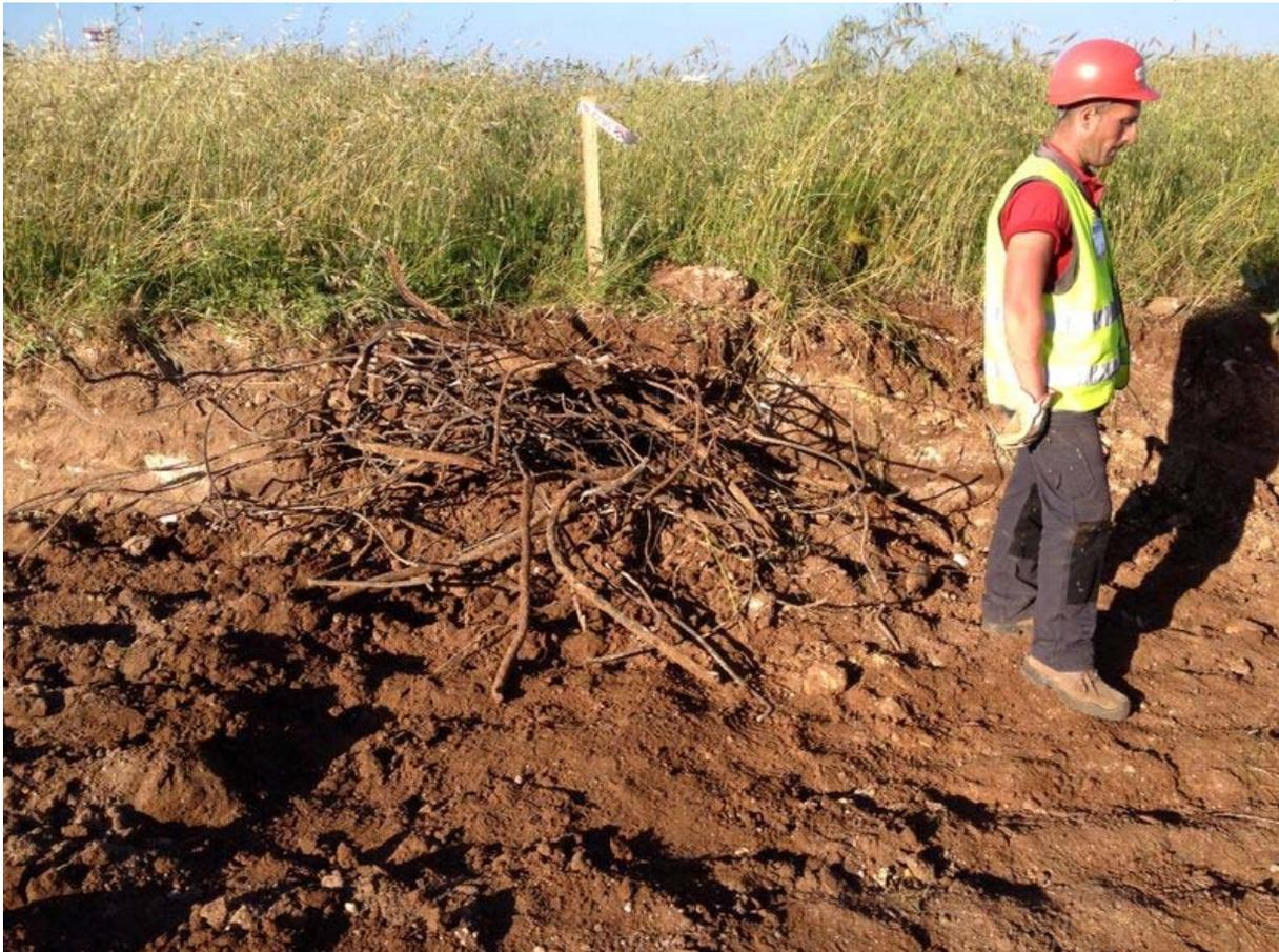
*Immagine 4 – Cernita del materiale escavato con raccolta ed accantonamento delle masse ferrose rinvenute*
