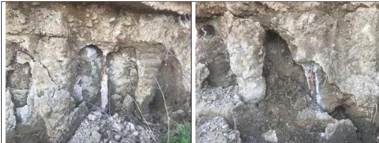
*Figura 5 – Consistenza e stato di conservazione della paratia*
