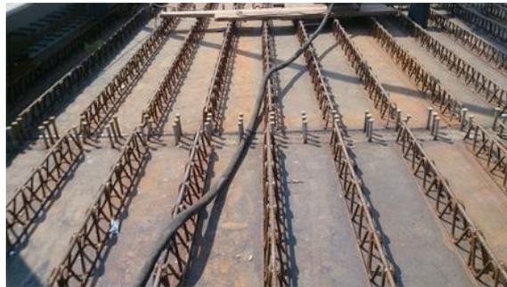
Figura 6: Tipologico lastra tralicciata di supporto soletta in cls
